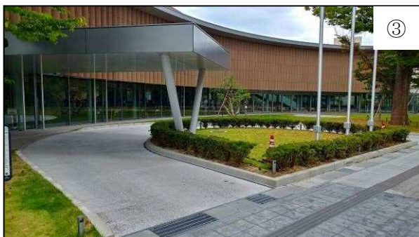
③ 建物が完成しました
