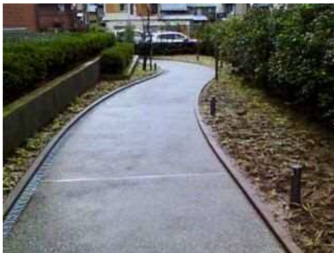
ヒーター敷設箇所
