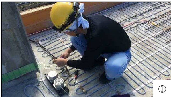
① ヒーターを敷設します
