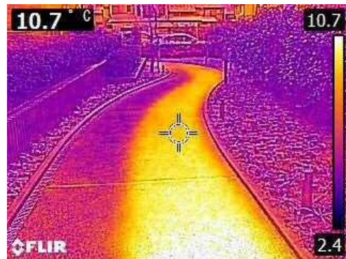
ロードヒーティング運転中
