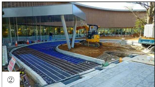
② 車路部分にヒーター敷設完了しました
